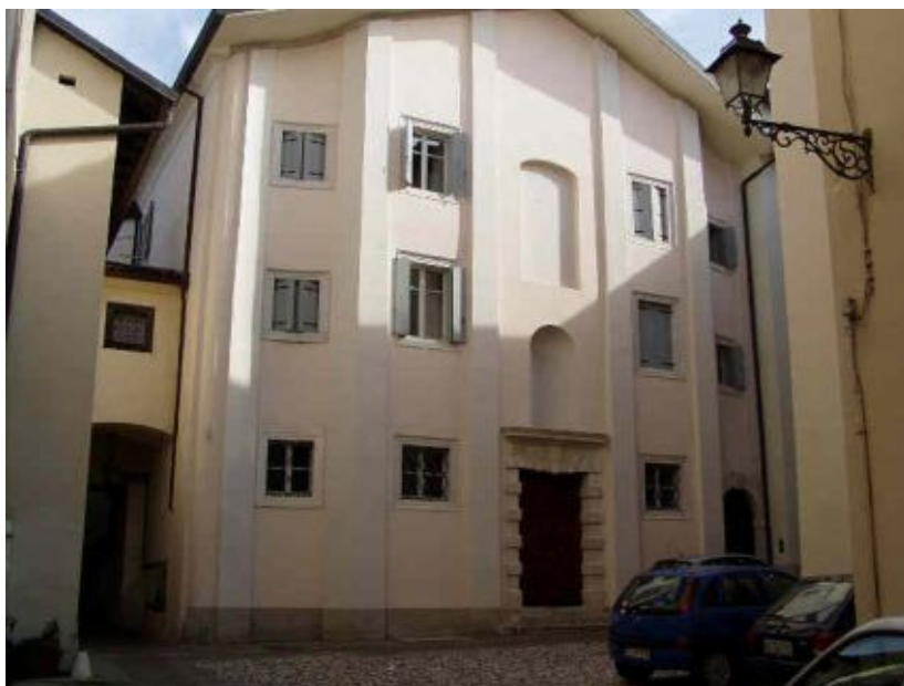
Edificio dell'antica chiesetta di S. Giuseppe; qui Rosmini aveva posto la sede dell'Oratorio. A sinistra si nota il passaggio aereo che collega con la chiesa di S. Marco.
